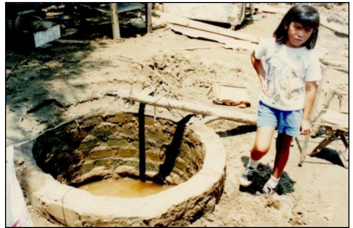
Foto 1: Pozo de agua inutilizable, los pozos también sufrieron daños en casi su totalidad y originando la escases de agua para consumo.
